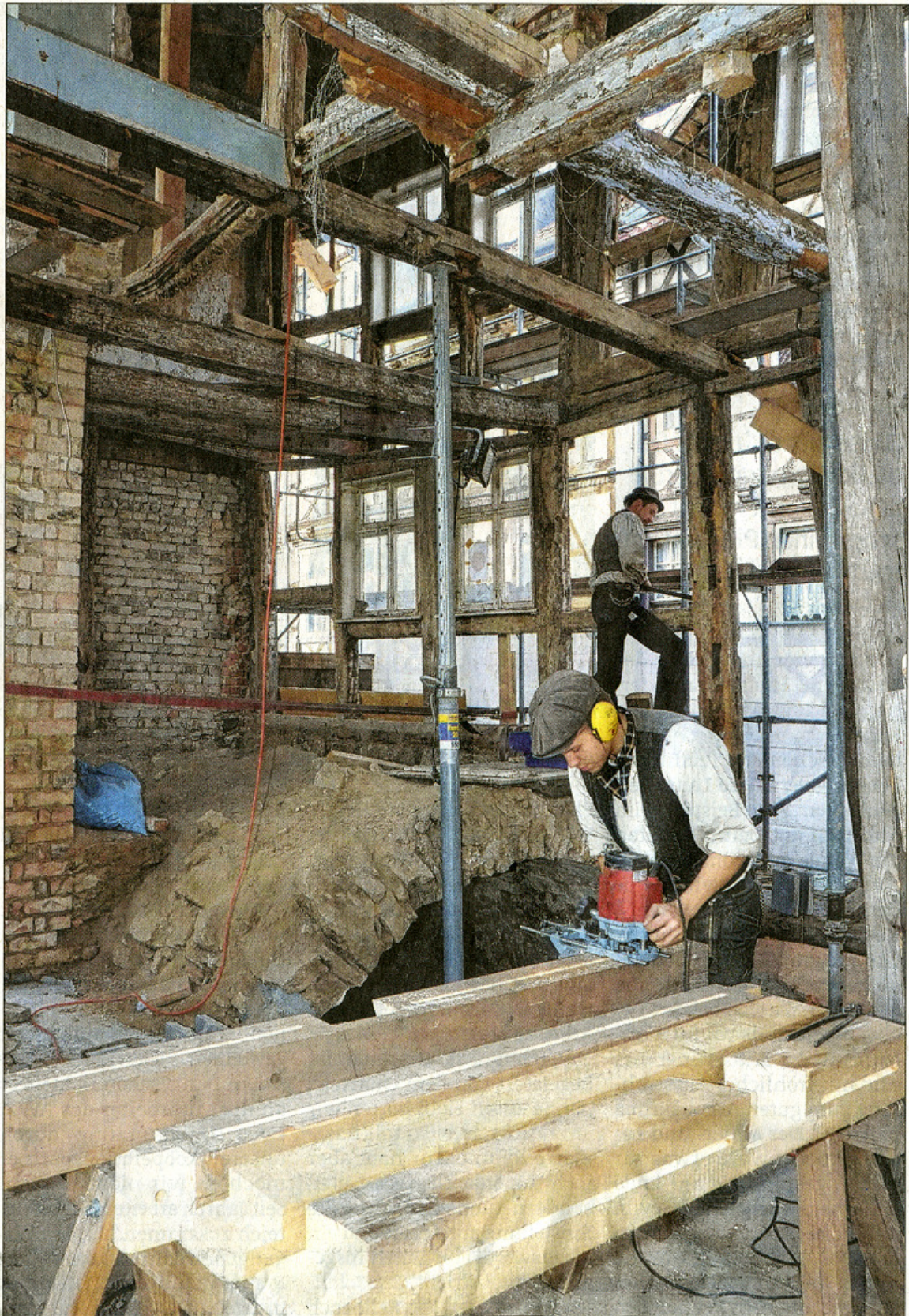
Hannes Blechinger fräst in neu angefertigte Balken Nuten, mit deren Hilfe in den Gefachen das Mauerwerk mit dem Holz verbunden wird.
